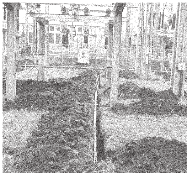
Fig. 1. Imagine de ansamblu a stației de transformare înaltă / medie tensiune, în timpul refacerii sistemului de pământare (Cluj-Napoca, 2005)
